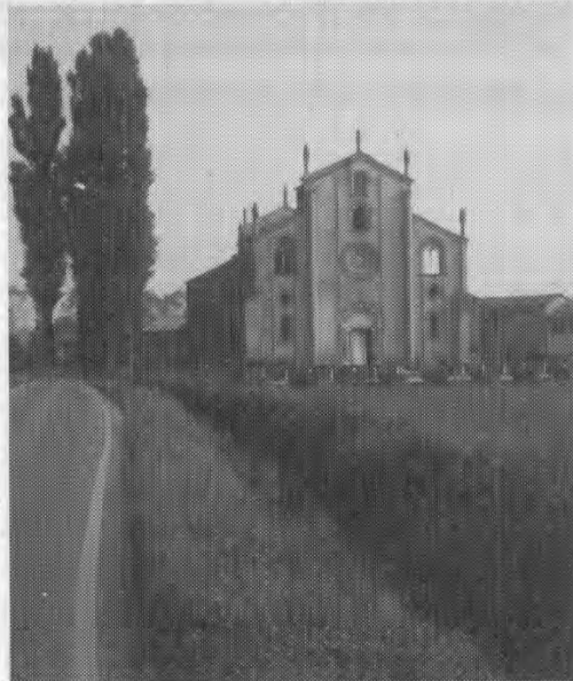
La Basilica di San Bassiano a Lodivecchio sorge isolata appena fuori l'abitato. In questa zona fiorì l'antica Laus Pompeia, distrutta dai milanesi durante le guerre contro l'imperatore Federico Barbarossa, che edificò la nuova Lodi nel 1158.
