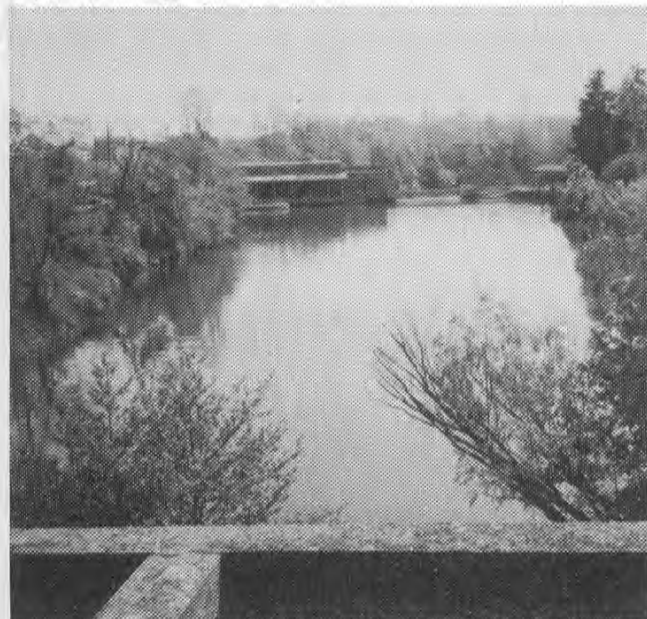
Un suggestivo scorcio della diga di Ceregallo sul fiume Lambro. In primo piano, il manufatto in cemento del «Canaròn», la condotta del Cavo Marocco che scavalca il Lambro.
