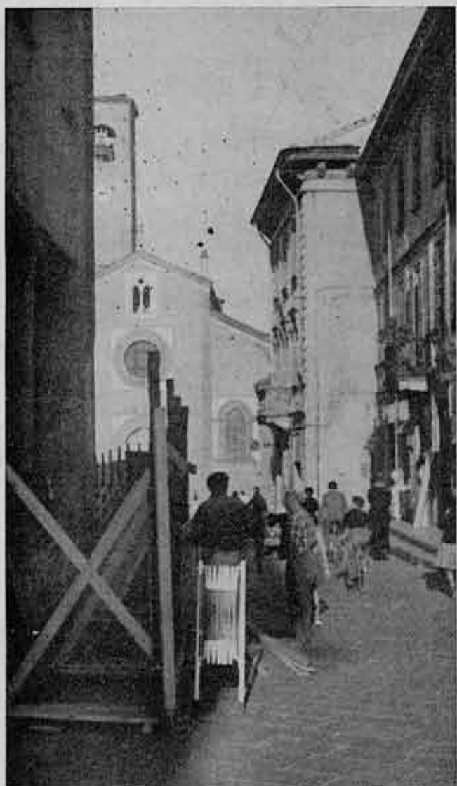
La strettola di Via Conciliazione all'epoca dei lavori per il nuovo palazzo del Comune.
