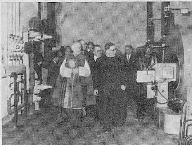
Le autorità in visita alla centrale termica. (Foto Besozzi)
