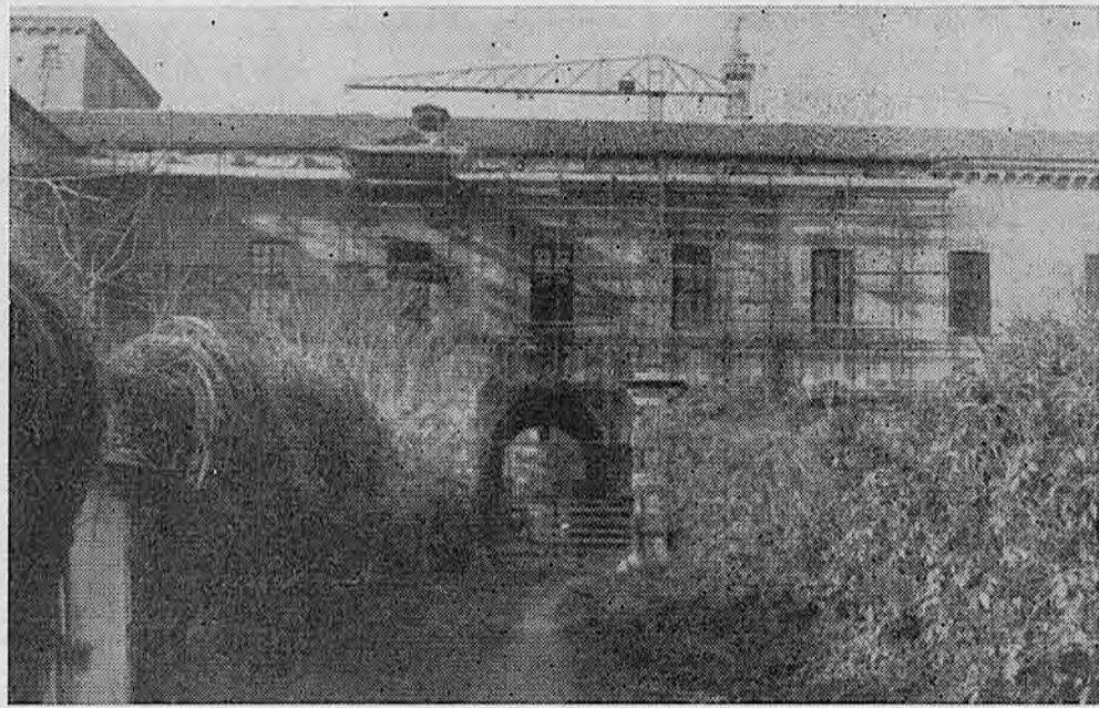
E' stato recentemente ultimato il rifacimento del tetto di una parte dei saloni di rappresentanza del Castello Mediceo e i lavori continuano per la ricomposizione della cornice. A lavori ultimati, questa parte del Castello sarà presa in affitto dal Comune e vi troveranno sede le associazioni e le istituzioni cittadine. (Foto Besozzi - Melegnano)
