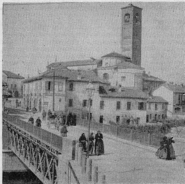
Il vecchio ponte sul Lambro all'epoca dei lampioni a gas.
